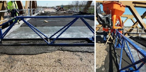
Revêtement BFUP pour l'étanchéité, mise en place à la règle, A36 © F. Toutlemonde, Université Gustave Eiffel
