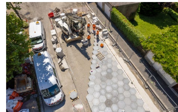
Le démonstrateur de CUD-SF de Nantes en cours de montage vu du ciel. ©Eiffage Route
